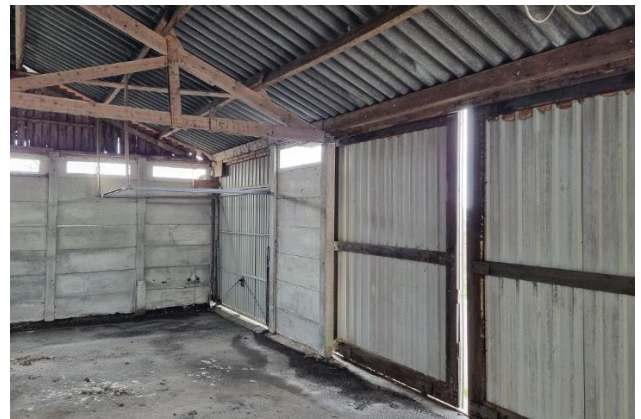
Figuren 11 en 12: Links, object A van de buitenkant gezien. Rechts, zicht op de binnenzijde van object A met betonnen vloer en golfplaten zijanten.
