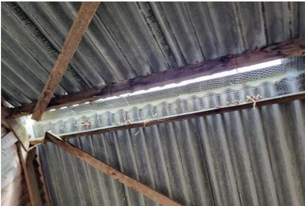
Figuren 13 en 14: Links, de nok van object A is gedeeltelijk afgeschermd met gaas. Rechts, bij één van de ramen is het glas eruit.
