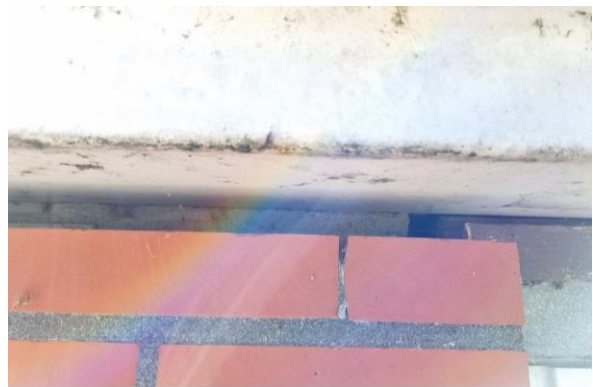
Figuren 11 en 12: Links, een overzichtsfoto stal A. Rechts, detailfoto van de muur onder de dakgoot waar duidelijk een open stootvoeg te zien is.
