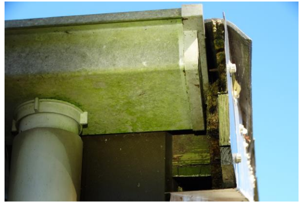
Figuren 9 en 10: Links, een overzichtsfoto stal A. Rechts, detailfoto van de dakgoot waarin duidelijk een opening zit naar binnen toe.
