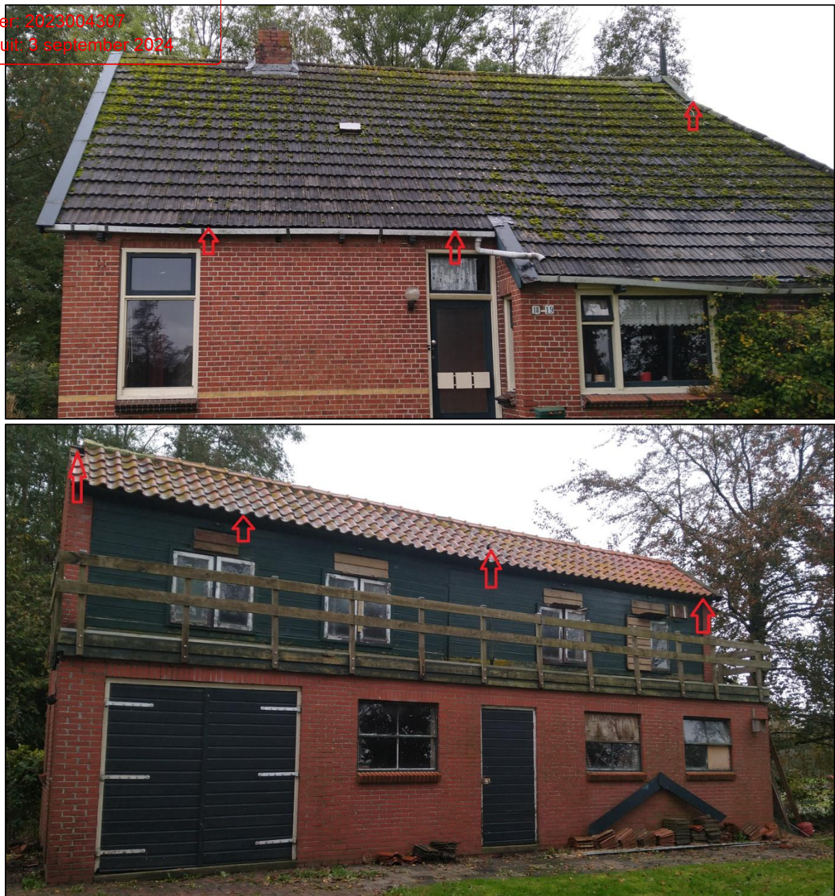
Figuur 2.1. De te slopen woning en de te restaureren schuur bieden nestgelegenheid voor huismussen (rode pijlen).
