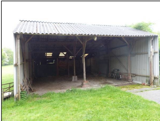
afbeelding 2.8. De kapschuur, van voren gezien.
