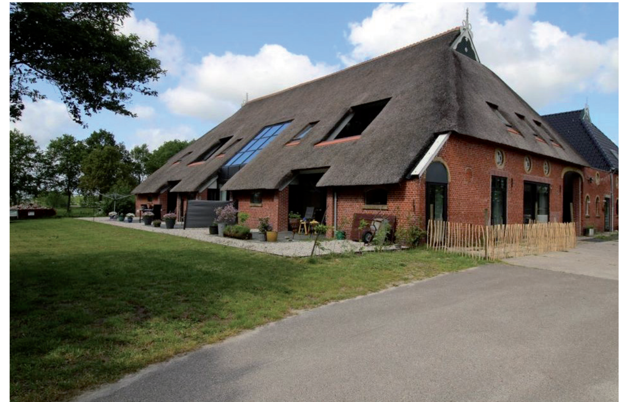
Zuidzijde van de schuur (Funda)
