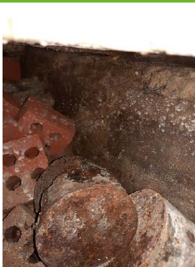
Foto 4.1: betonnen bak ter plaatse van voormalige ondergrondse tank
