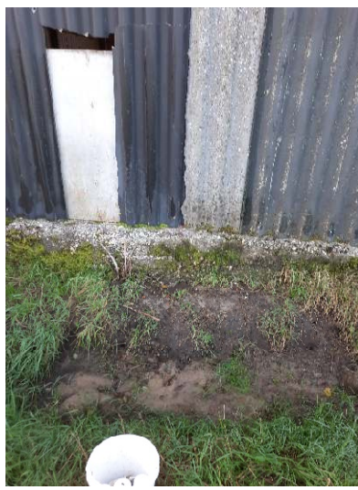
Foto 5.2: onverharde maaiveld noordelijke loods
