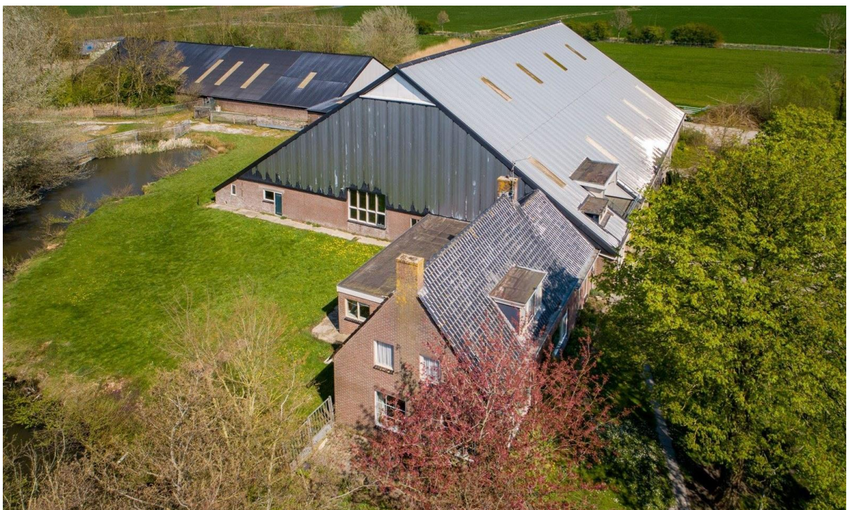
Figuur 3. Bestaande bedrijfswoning met aanpandige bedrijfsbebouwing.
