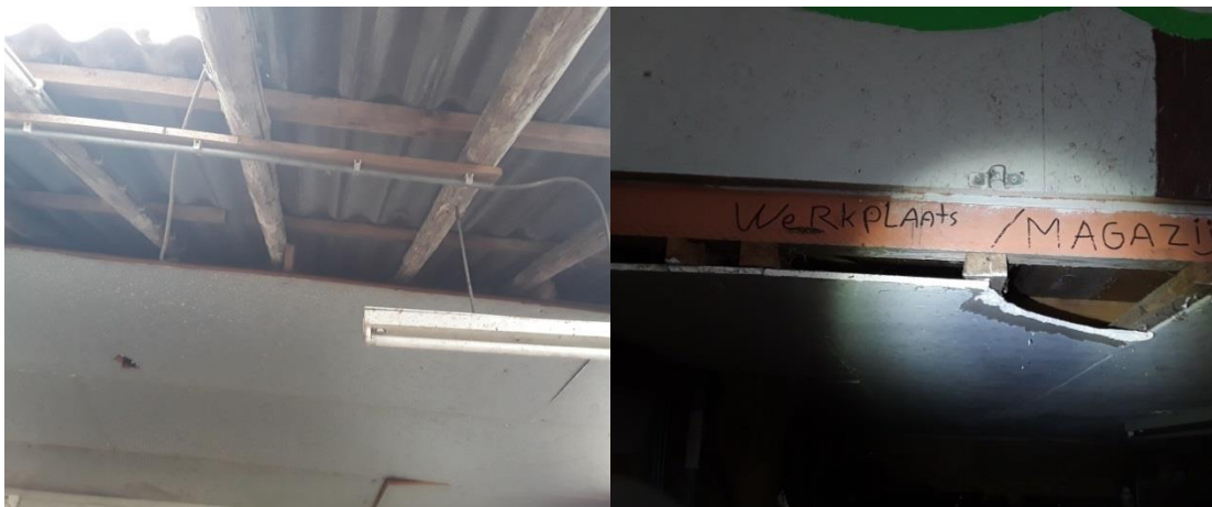
Foto 5 Plafond- en dakbetimmering zijn potentiële verblijfplaatsen voor vleermuizen
