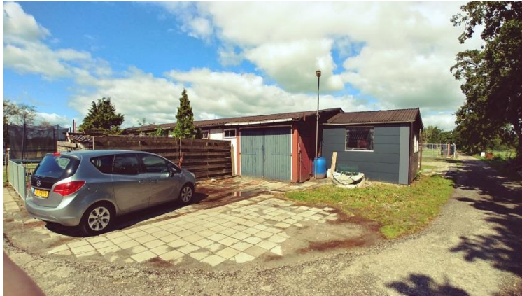
Foto 1 Zijkant van de schuur.
