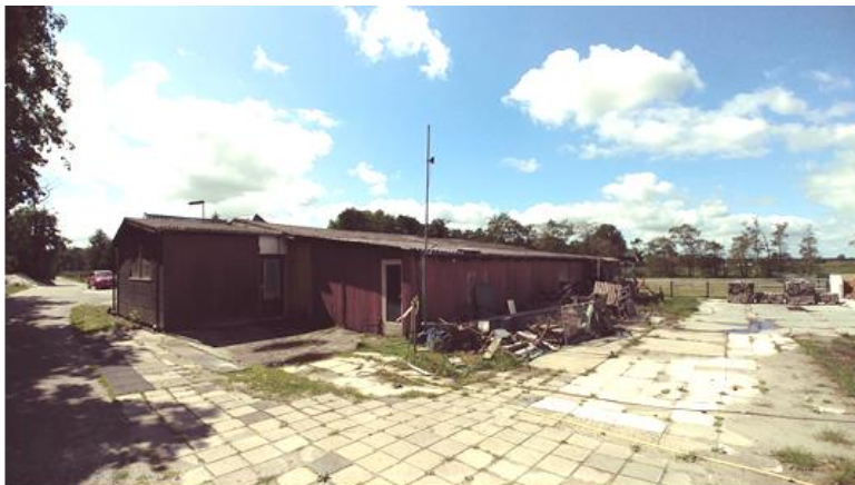
Foto 3 Achterkant van de schuur.
