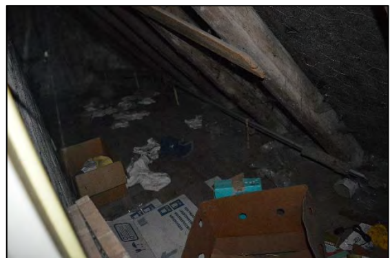
Afbeelding 2.17. Berging onder dak noordzijde woning.
