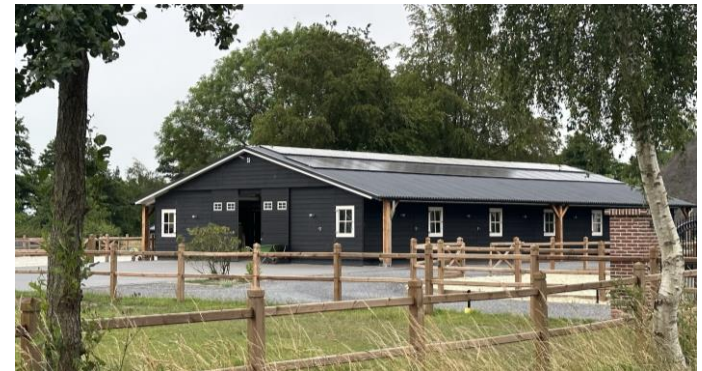
Paardenstal van circa 5 meter hoog en 10 meter breed, opgetrokken uit donkere houten gevelbekleding.
