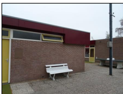
Figuur 7. Vooraanzicht te slopen kleedkamers, gezien vanuit het zuidwesten.
