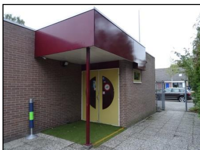
Figuur 4. Zijaanzicht te slopen clubgebouw, gezien vanuit het zuidoosten.
