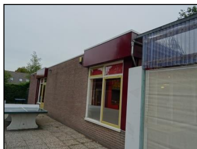
Figuur 5. Zijaanzicht te slopen clubgebouw, gezien vanuit het zuidwesten.
