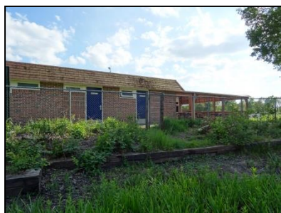
Figuur 6. Te slopen kleedkamers en kantine van VV Zevenhuizen.
