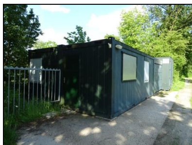
Figuur 3. Te slopen bebouwing grenzend aan de voormalige ijsbaan.
