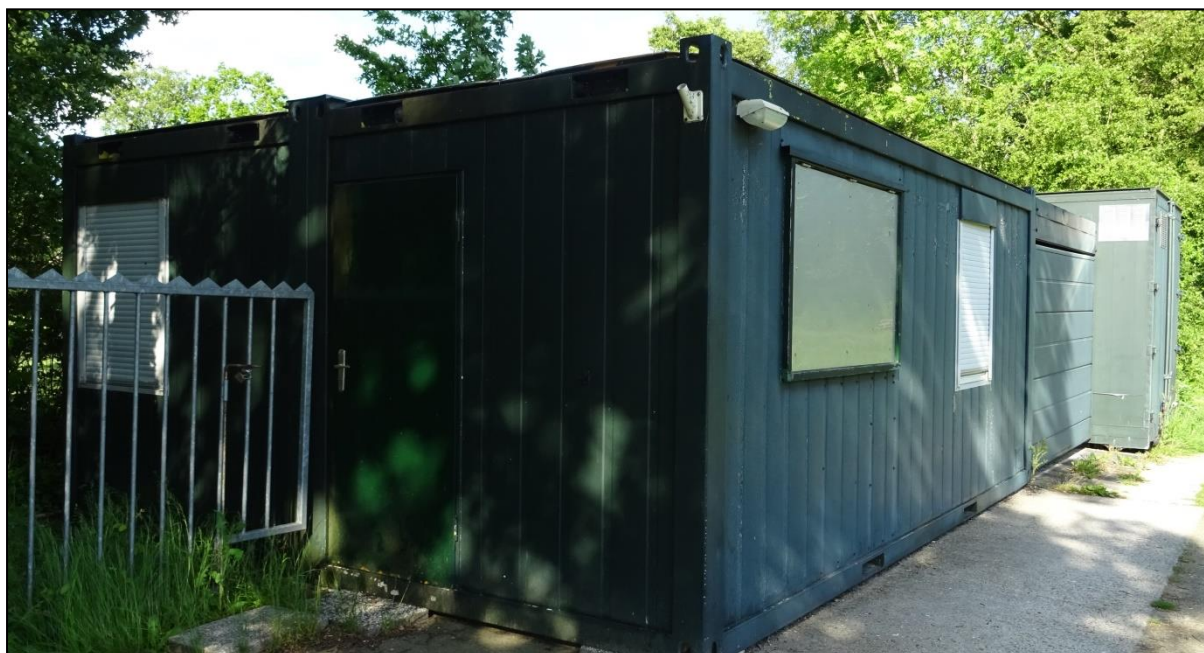
Figuur 10. Detailfoto van de te slopen bebouwing naast de voormalige ijsbaan.
