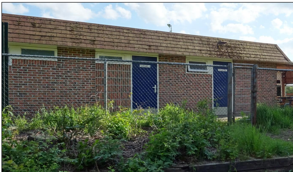
Figuur 9. Detailfoto van de te slopen kleedkamers en kantine van VV Zevenhuizen.
