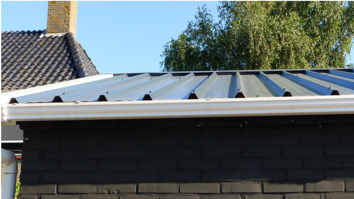
Figuur 4.2 Het bedrijfsgebouw bevat geen geschikte broedgelegenheden.
