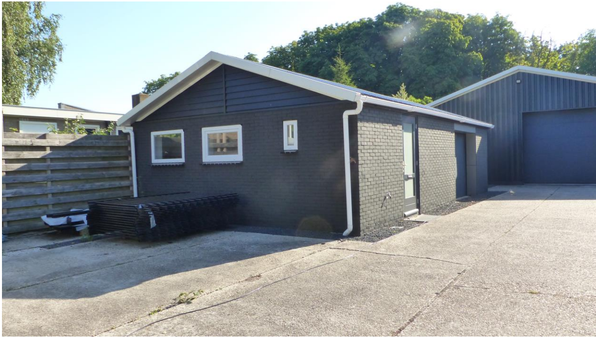
Figuur 1.4 Het te slopen bedrijfsgebouw.
