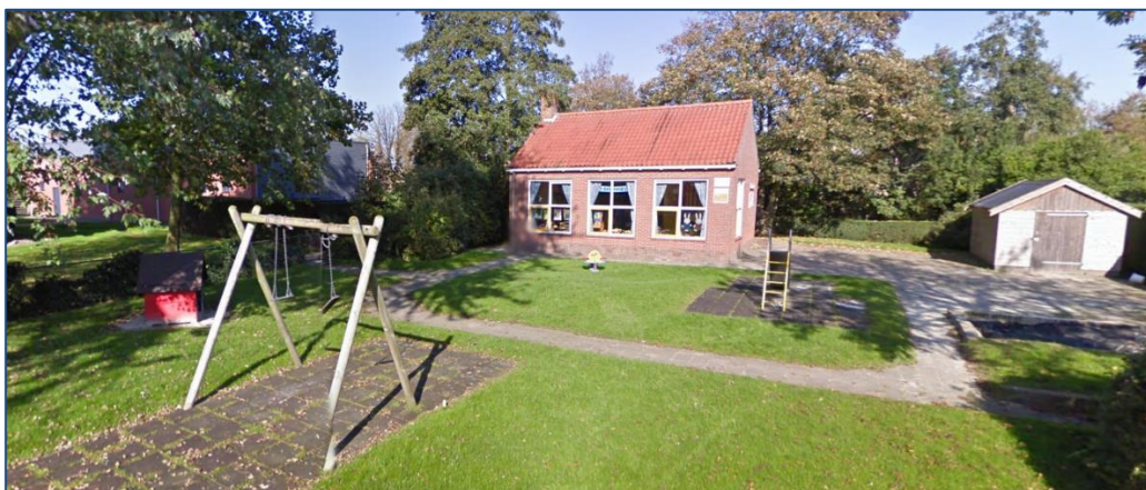
Fig. 2.2: Een weergave van de voormalige kinderdagverblijf in het plangebied, gezien vanaf de Pastorijlaan.
