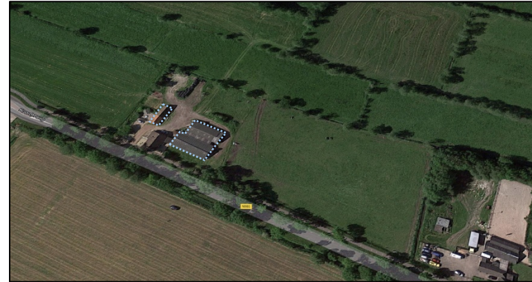
Figuur 3 Te slopen opstallen
