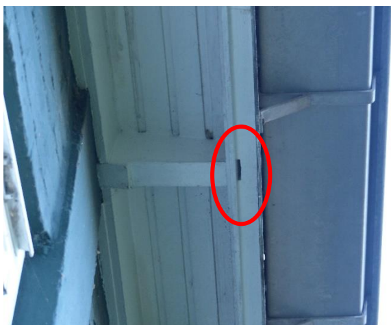
Figuur 14. Vierhoeken gaten in de betimmering en ruimte tussen de betimmering en bakstenen.
