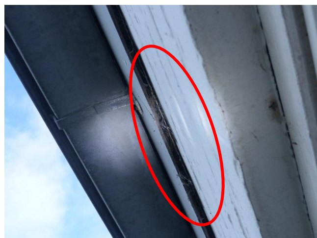
Figuur 15. Gleuf tussen bakstenen en aluminium daklijsten en tussen betimmering en bitumen.
