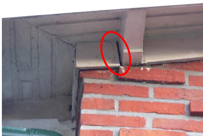
Figuur 16. Verticale gleuven en ruimtes tussen betimmering en bakstenen.
