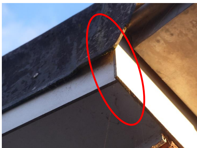
Figuur 14. Vierhoeken gaten in de betimmering en ruimte tussen de betimmering en bakstenen.
