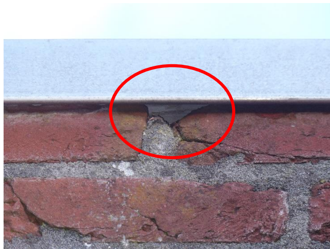
Figuur 14. Vierhoeken gaten in de betimmering en ruimte tussen de betimmering en bakstenen.
