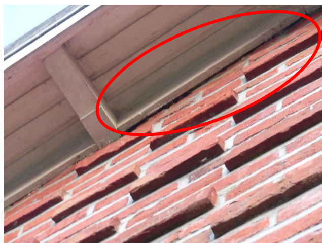
Figuur 14. Vierhoeken gaten in de betimmering en ruimte tussen de betimmering en bakstenen.
