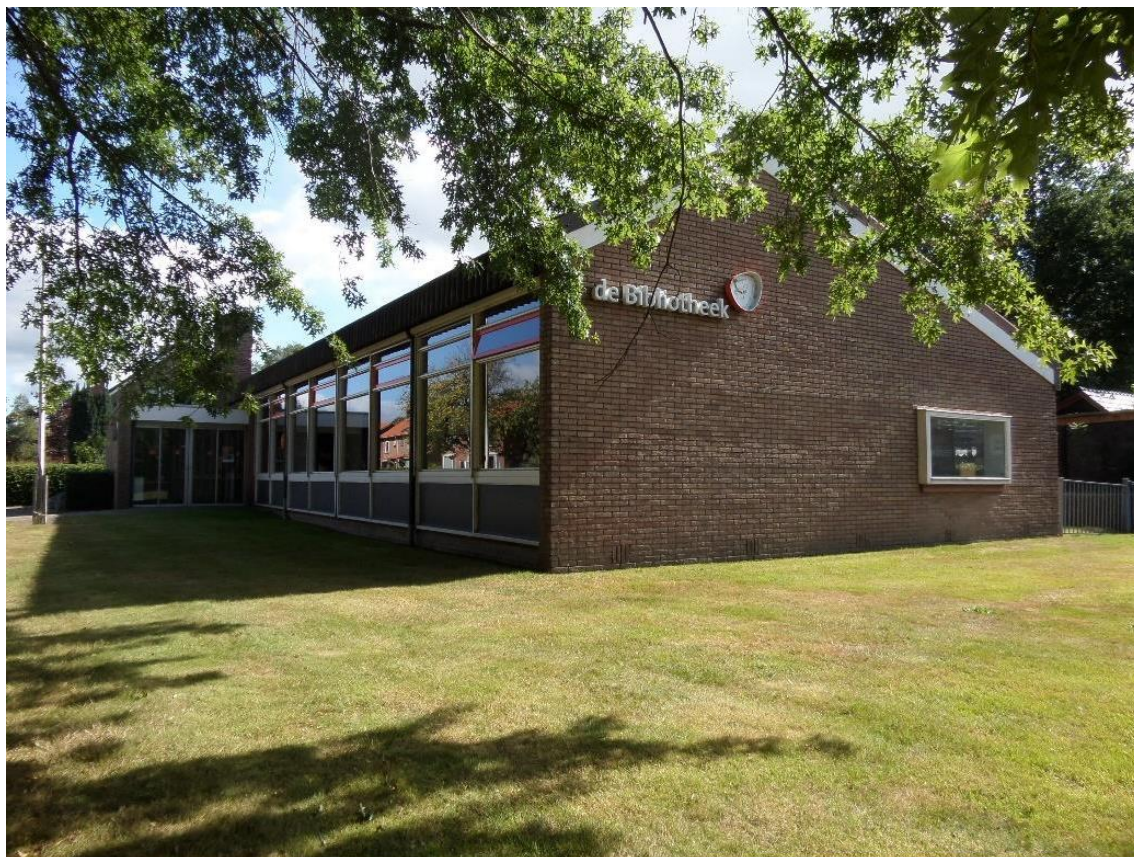
Figuur 4. De bibliotheek met het omringende perceel met gras.
