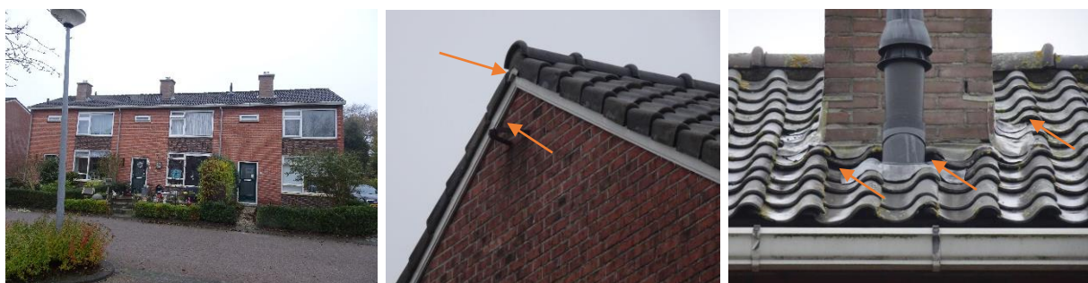
Figuur 17 Actuele situatie in de Centrumstraat (even huisnummers) te Opende op 11 november 2021. Links: een overzicht van een van de woningblokken in de Centrumstraat. Midden: potentiële invliegopeningen voor vleermuizen en gierzwaluwen. Rechts: ruimte tussen dakpannen (vleermuizen) en geschikte dakgoot voor huismussen om onder de dakpannen te broeden.
