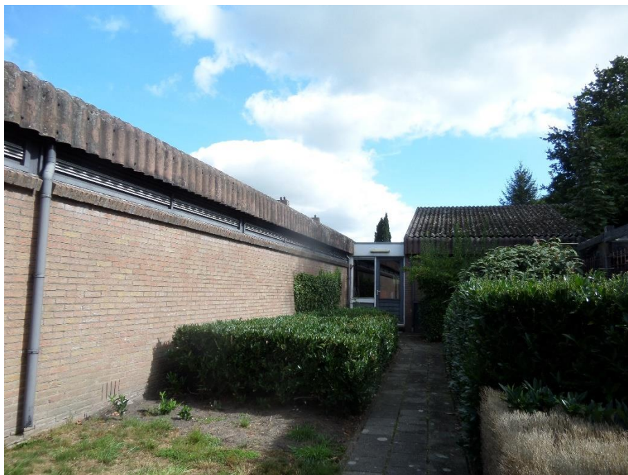
Foto 2 De achterzijde van de bibliotheek, met rechts een aanbouw.
