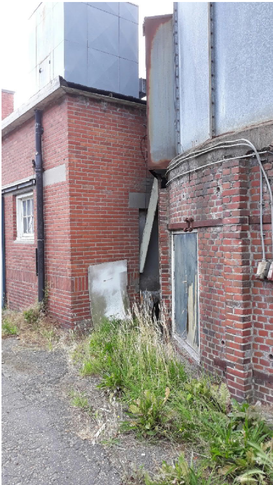
Foto 9: locatie 2: voormalige ondergrondse tank
