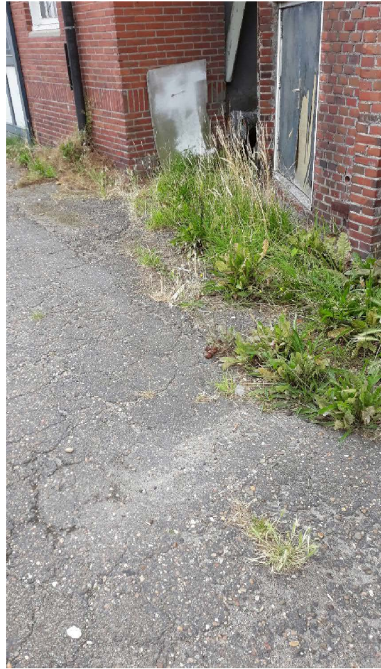
Foto 10: locatie 2: voormalige ondergrondse tank
