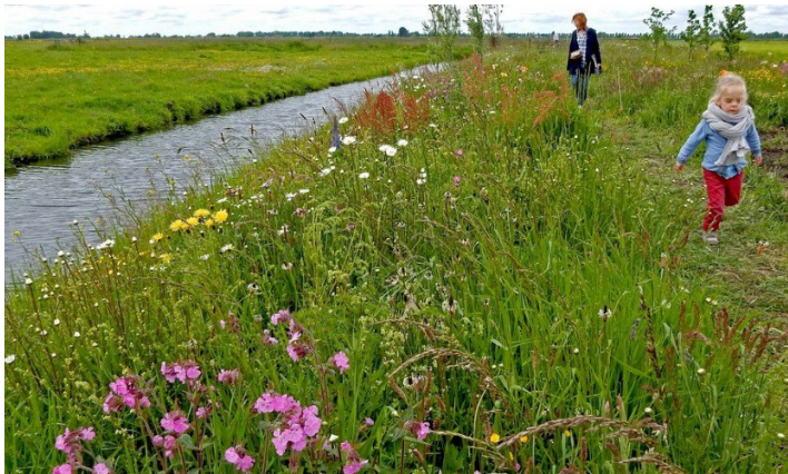
Afbeelding 2: natuurvriendelijke oever met flauw talud
