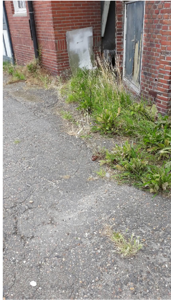
Foto 10: locatie 2: voormalige ondergrondse tank
