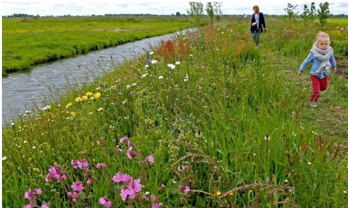
Afbeelding 2: natuurvriendelijke oever met flauw talud
