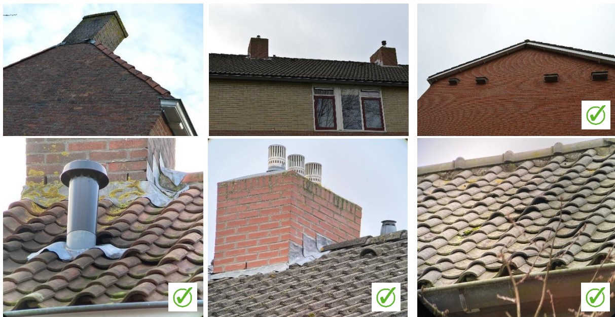
Figuur 8 Voorbeelden van daken waar wel (zie groene vinkjes) of juist geen potenties voor gierzwaluwen aanwezig zijn. De linker twee foto's in de bovenste rij laten zien dat de toegang onder de dakpannen geblokkeerd is, omdat de dakpannen allemaal strak tegen de gevel liggen en/of netjes op elkaar aansluiten. Bij de rechter foto in de bovenste rij zijn zelfs specifiek voor deze vogelsoort nestkasten opgehangen. Linksonder liggen de pannen wat slordig op het dak, waardoor ruimtes ontstaan voor gierzwaluwen om onder de pannen te schieten. Op de middelste foto in de onderste rij is het rooster uit een ventilatiepan verdwenen, waardoor ook hier een opening ontstaat waar een gierzwaluw de ruimte onder de dakpannen zou kunnen bereiken. Op de laatste (rechter) foto liggen de pannen ook weer wat slordig op het dak, maar is dicht bij de goot ook sprake van begroeiing die de invliegopeningen die hier potentieel beschikbaar zijn mogelijk wat belemmert.
