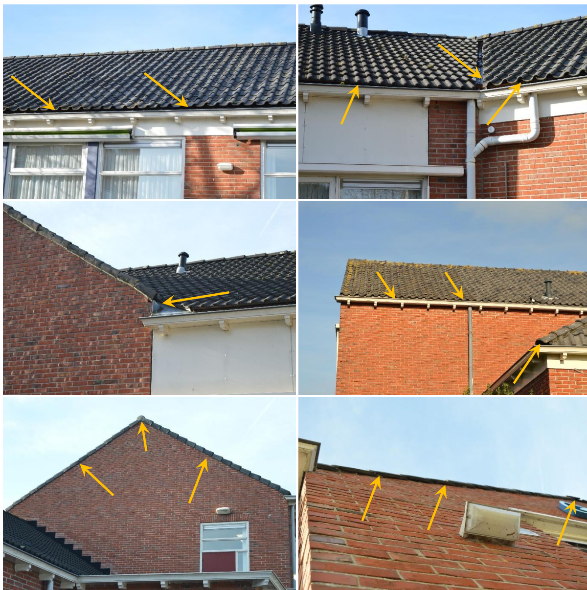
Figuur 11 Voorbeelden van potentiële invliegopeningen (pijltjes) voor huismussen en vleermuizen bij het voormalige schoolpand aan de Van Panhuyslaan 16 te Leek. Boven en midden: potenties voor huismussen. Beneden: potenties voor vleermuizen. Foto's: Bureau Biota.
