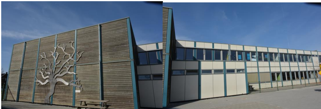
Foto 2 Impressie van het zijaanzicht van het schoolgebouw.
