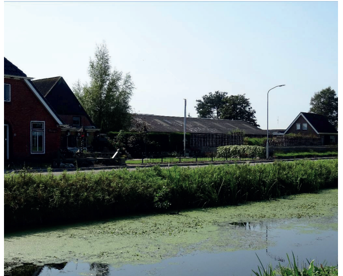
2.7 Zicht op het erf vanaf de overkant van de vaart. De huidige sleufsilos zorgen voor een verrommeld beeld.
