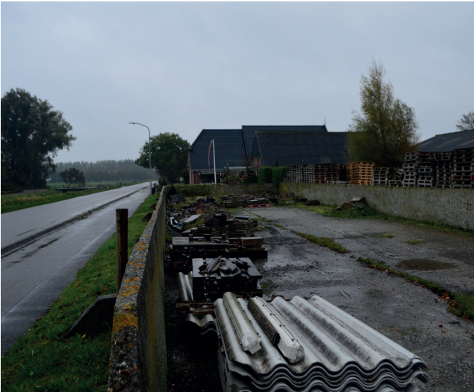
2.3 Zicht vanaf de sleufsilo's richting het woonhuis. De sleufsilo's worden verwijderd.
