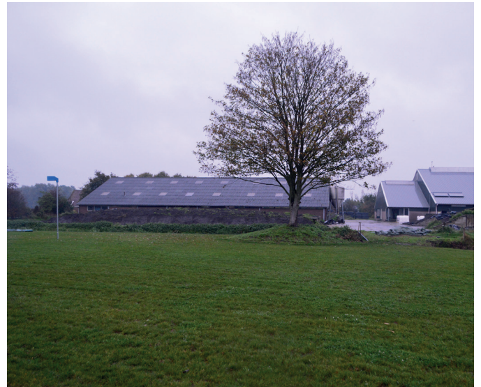
2.9 Zicht vanaf het achtererf richting de burens. De mestlo is reeds verwijderd.
