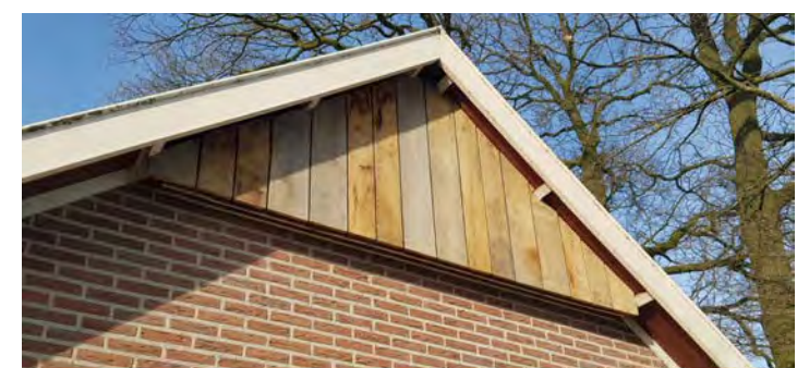
Gevelbetimmering tbv vleermuizen.
