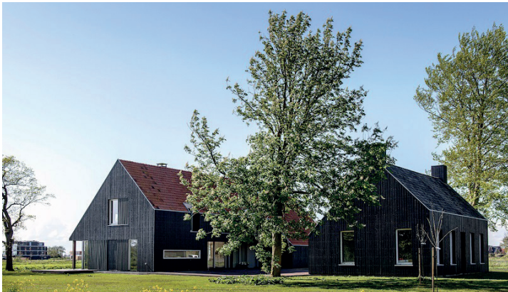
Erfensemble: bebouwing met beplanting.
