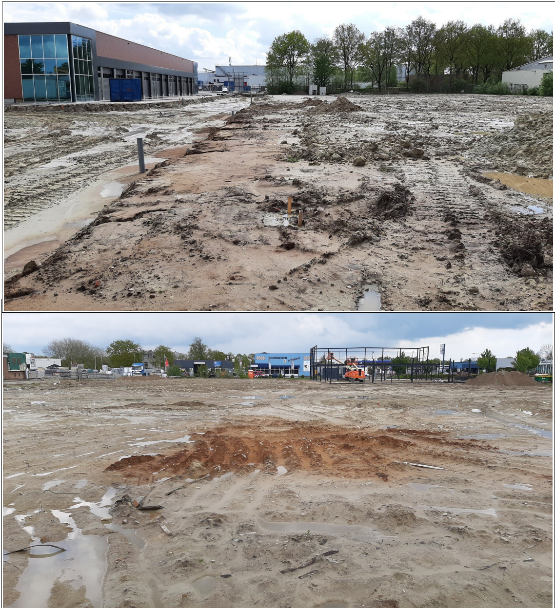
Figuur 2: Leek, Industriepark: de bovenste foto is genomen in zuidelijke richting, de onderste foto in oostelijke richting. Op de bovenste foto zijn een weg in aanleg en een nieuwe loods zichtbaar, op de onderste foto is men achteraan bezig met de bouw van een loods.
