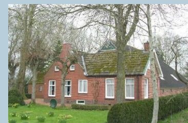
Carolieweg 24 Zevenhuizen Kop-rompboerderij met uitgebouwd voorhuis uit circa 1890. Voorhuis in ambachtelijk-traditionele stijl gebouwd in twee bouwfases. Gelegen aan zijkant van breed erf met naastgelegen stookhut. Beeldbepalende ligging in het buitengebied ten zuidwesten van de bebouwde kom van Tolbert. Zeldzaam vanwege het type van uitgebreide kop-rompboerderij.
