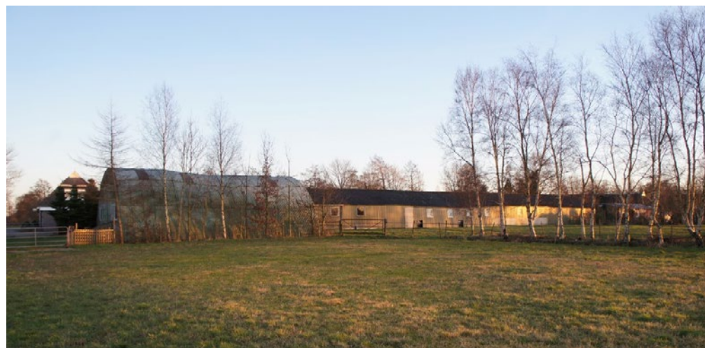
Zicht op het erf met de te slopen Romneyloods vanuit het noorden gezien.
