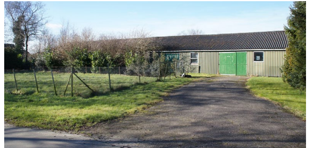
Bestaande oprit en deel van de schuur welke gesloopt zal worden.
