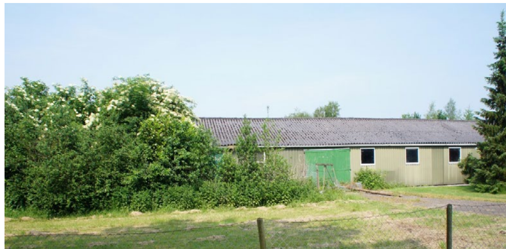
Te slopen gedeelte van schuren en huidige erfbeplanting.
