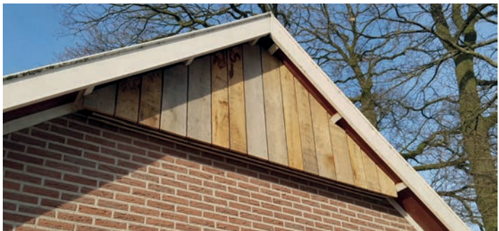
Gevelbetimmering tbv vleermuizen.
