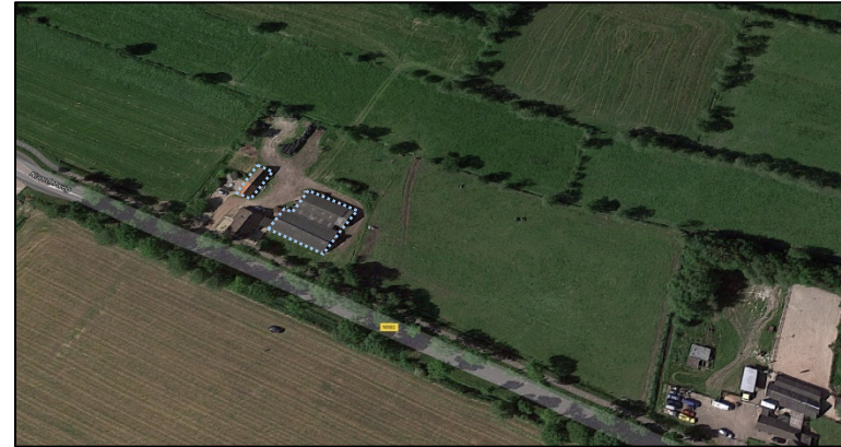
Figuur 3 Te slopen opstallen
