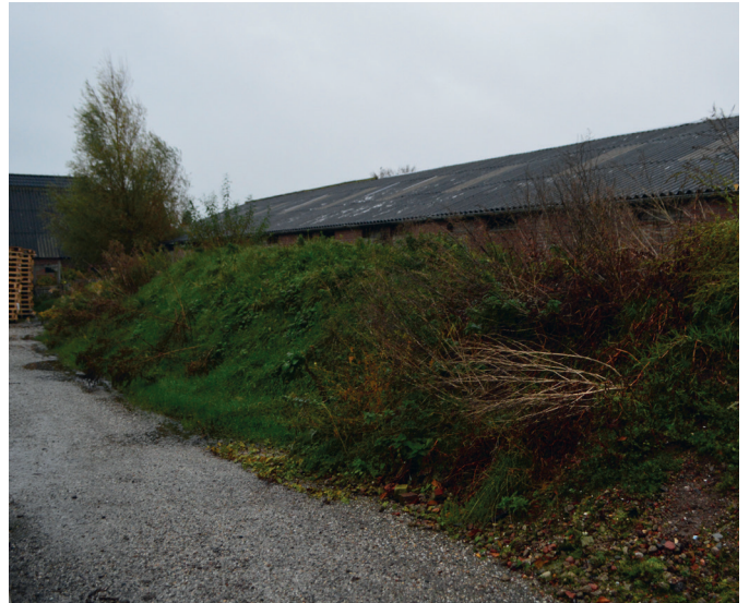
2.4 Zicht vanaf de sleufsilo's richting schuur 1. Schuur 1 wordt verwijderd.
