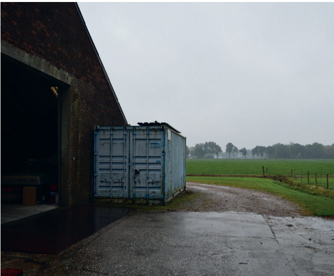
2.5 Zicht vanaf het erf richting het open landschap. Schuur 2 wordt gerenoveerd.
