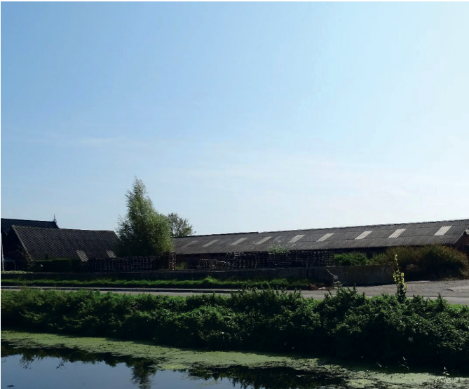
2.8 Zicht op het erf vanaf de overkant van de vaart. De voorste loods zal worden afgebroken.
