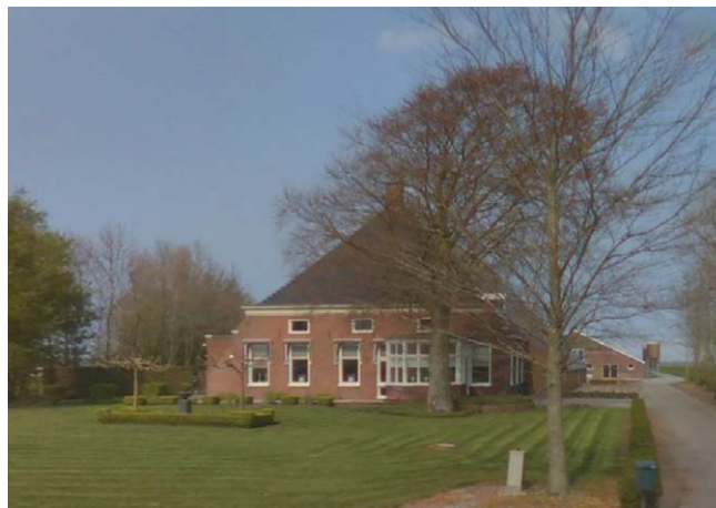
Stelpboerderij Stadsweg 70, Lauwerzijl (gemeentelijk monument)
