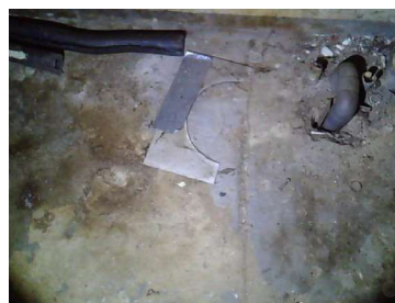
Foto 11. Losliggende plaat voorraadkamer
