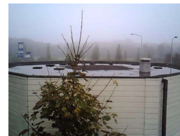
Foto 10. Niet-asbesthoudend dakleer
