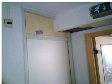
Foto 4. Niet-asbesthoudende beplating als bovenlicht boven deur
