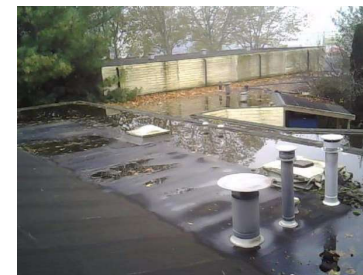
Foto 8. Niet-asbesthoudend dakleer
