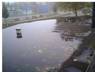
Foto 9. Niet-asbesthoudend dakleer
