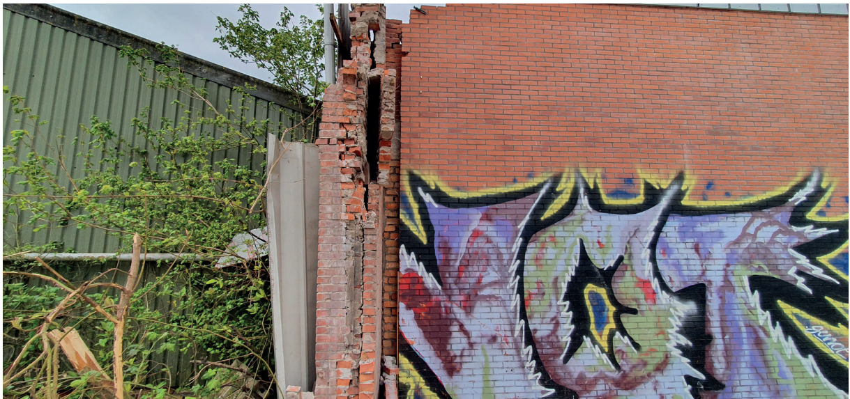
Figuur 8. Een deel van het voormalig 'Bobenco' pand met spouwmuur.
