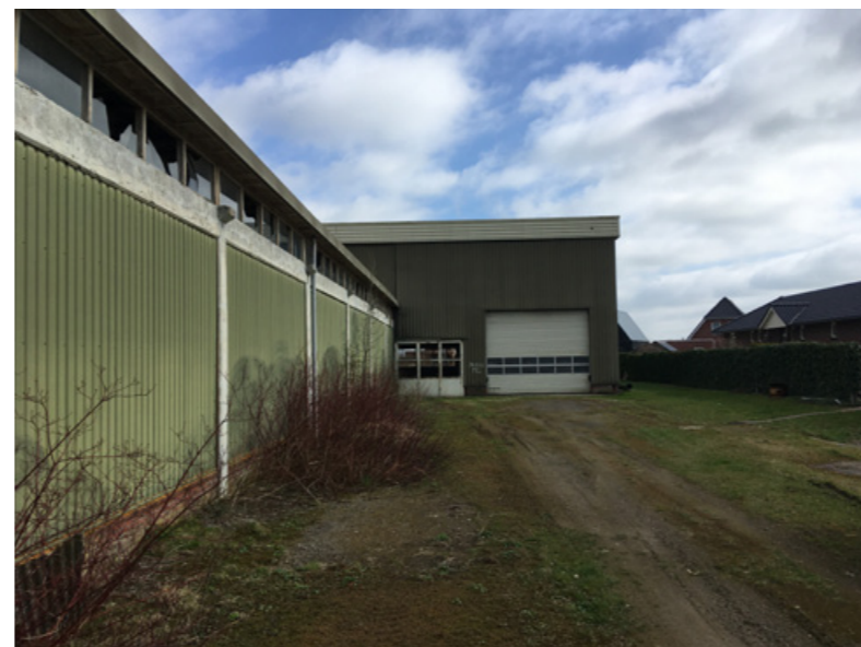
8. Te slopen bebouwing op het terrein.
