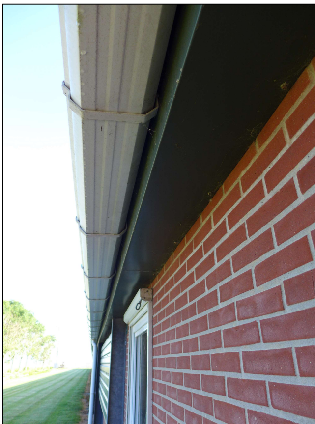
De afwerking van de aansluiting gevel-goot.
