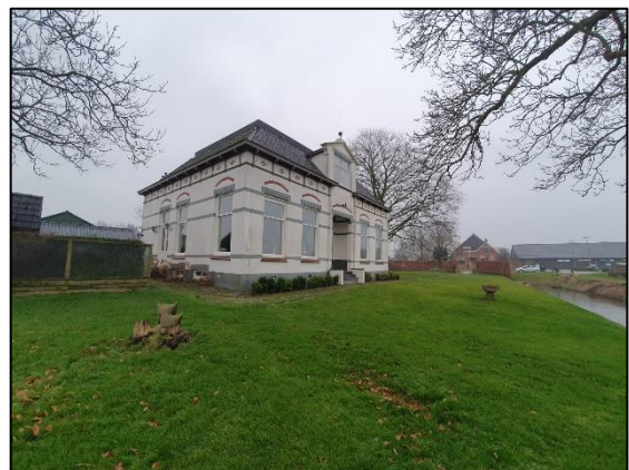
Afbeelding 2.3. Westzijde aanwezige bebouwing.
