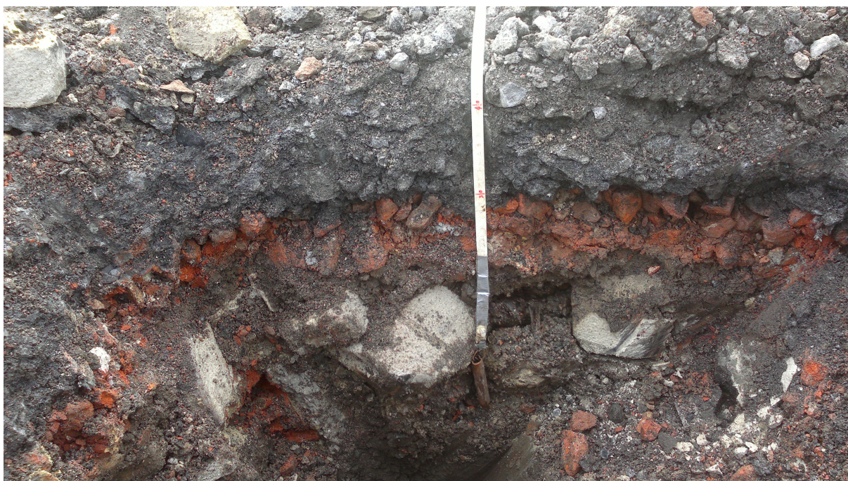
Foto 8. Slakken en puinlaag.
