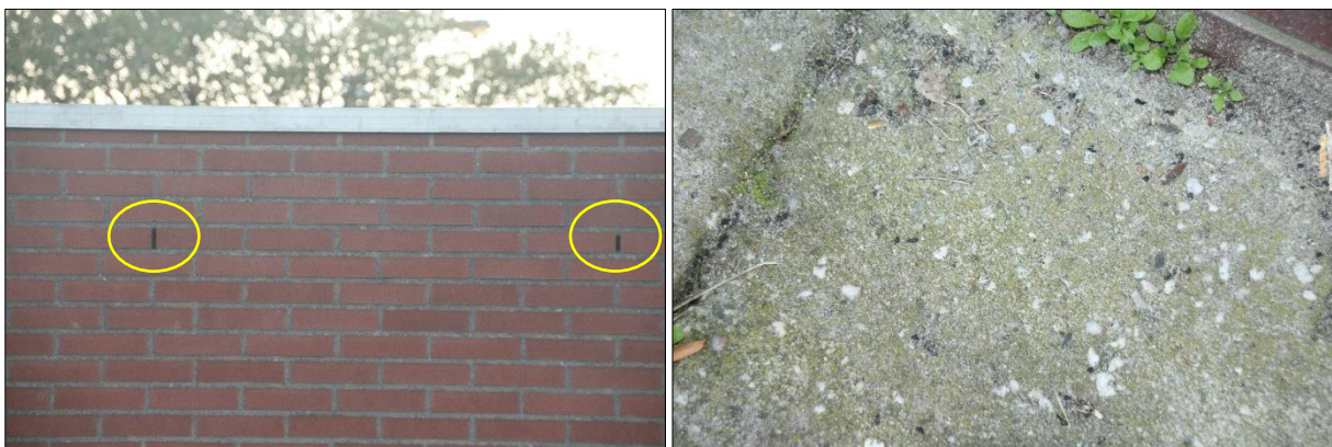
Foto links: open stootvoegen (gele cirkels) aangetroffen aan de gevels van het clubgebouw. Foto rechts: uitwerpselen van vleermuizen aangetroffen naast het clubgebouw onder open stootvoegen.
