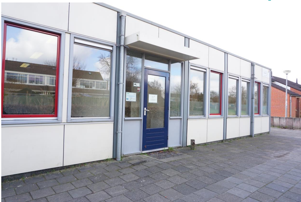
Figuur 1.4 Het noordwestelijke blok heeft kunststof panelen in plaats van bakstenen gevels.
