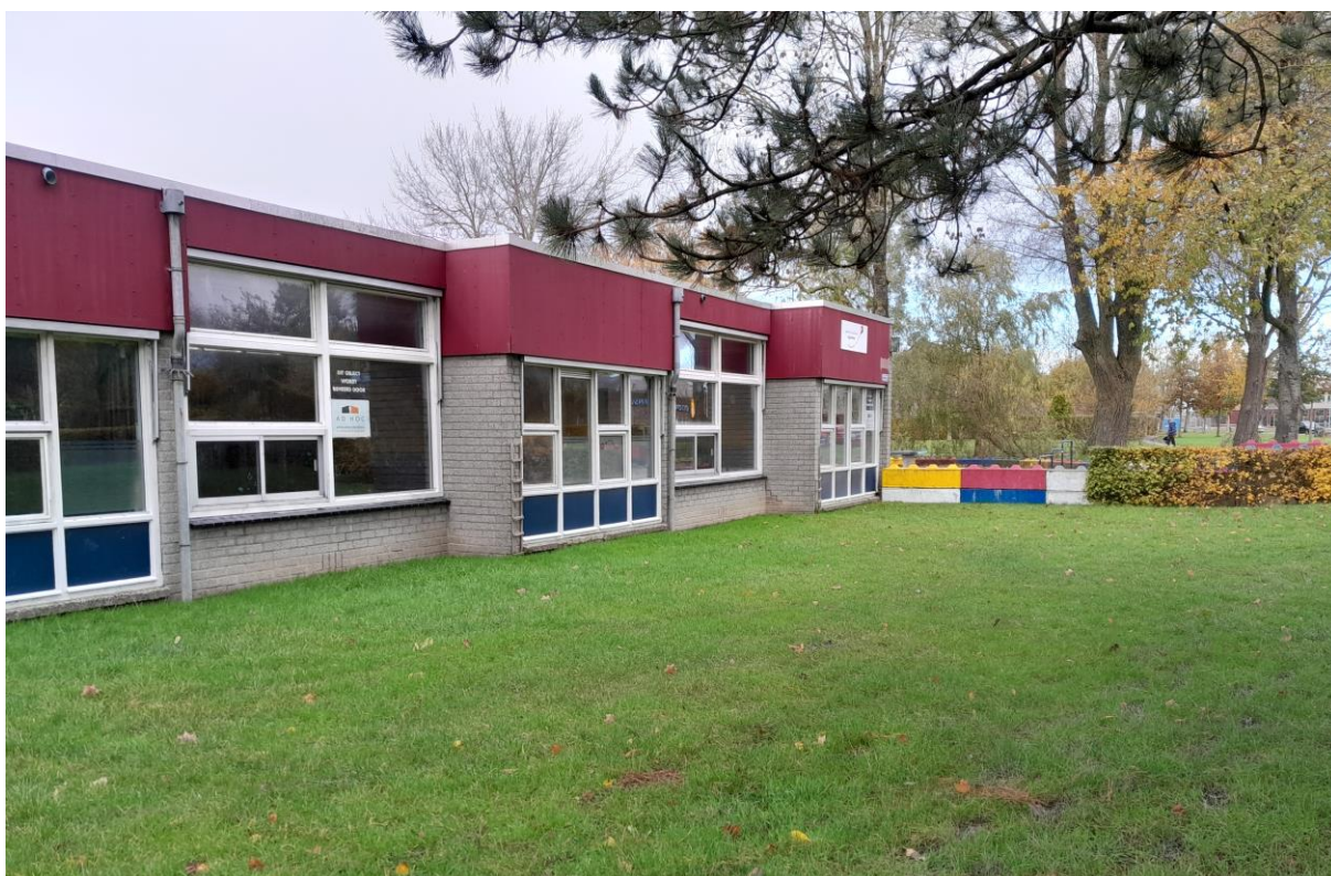
Figuur 1.3 De gevels bevatten veelal grote ramen.
