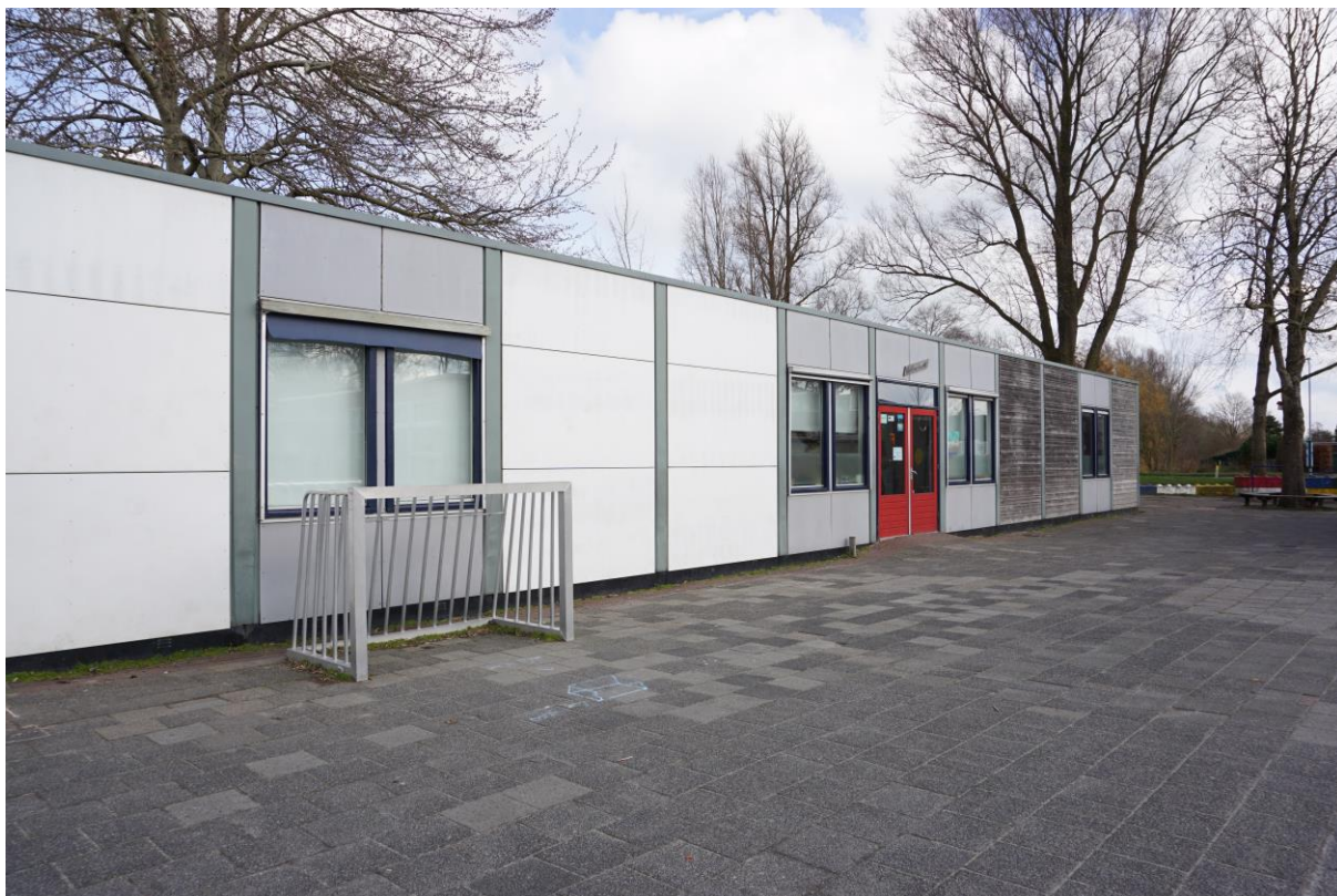
Figuur 1.5 Het bijgebouw bestaat uit kunststof en houten gevels.
