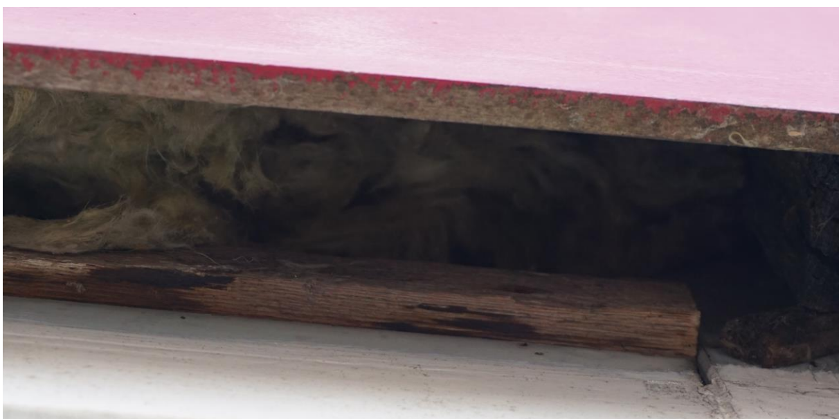
Figuur 4.3 De boeiboorden zijn gevuld met steenwol.
