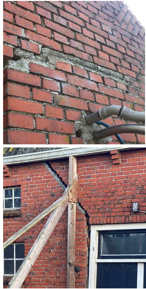
Foto's ter ondersteuning scheurvorming in vloer en wand in en rondom de woning.
