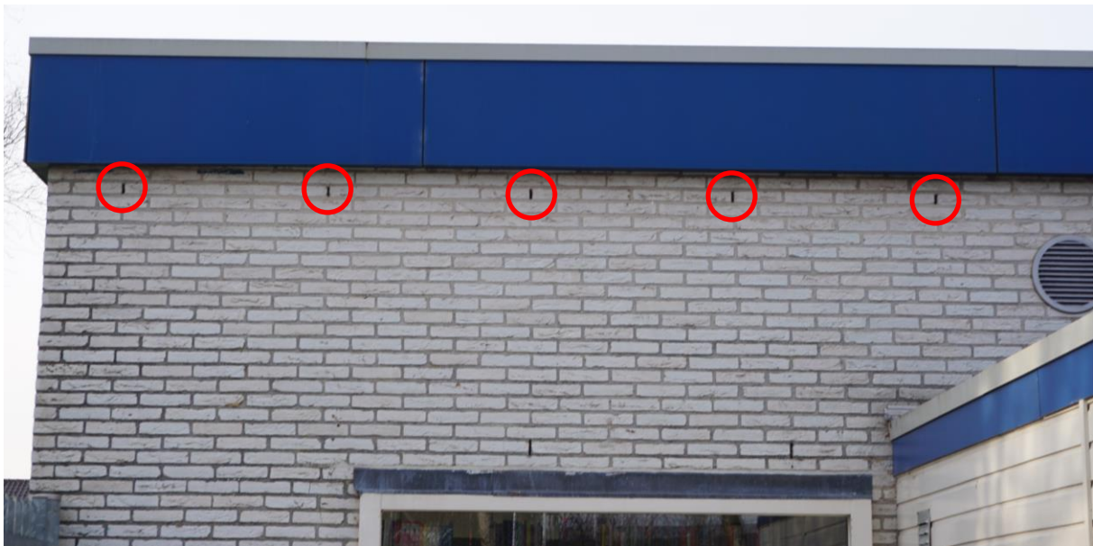
Figuur 4.5 Langs de gehele gevel van het zuidoostelijke gebouw zijn open stootvoegen aanwezig.
