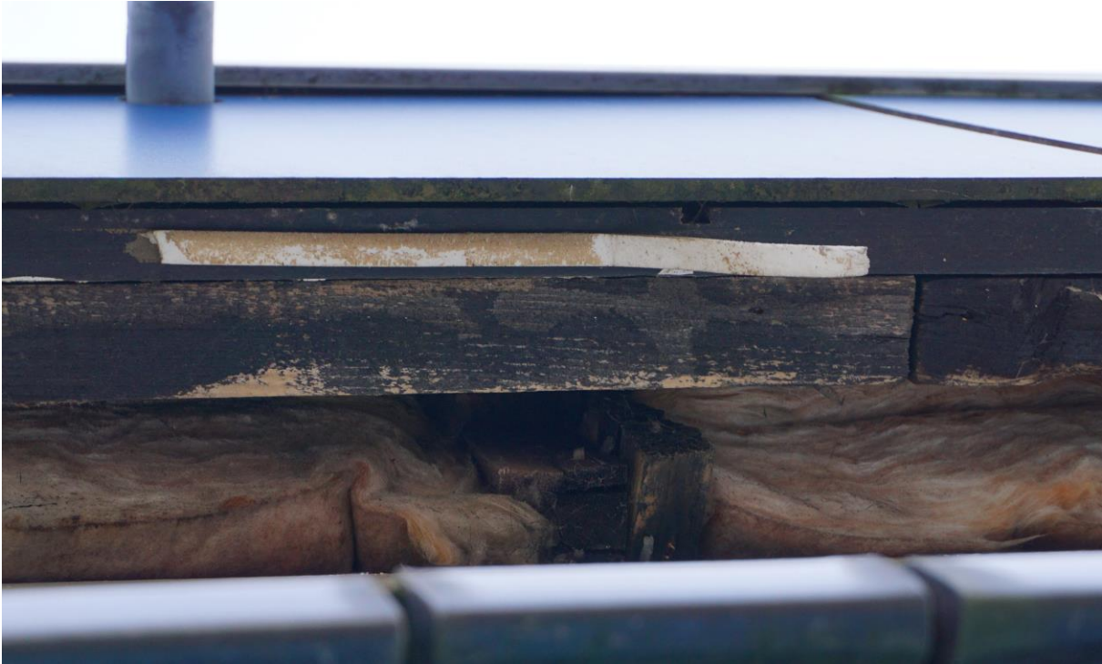
Figuur 4.4 De ruimte tussen het boeiboord en de gevel is grotendeels gevuld met steenwol.
