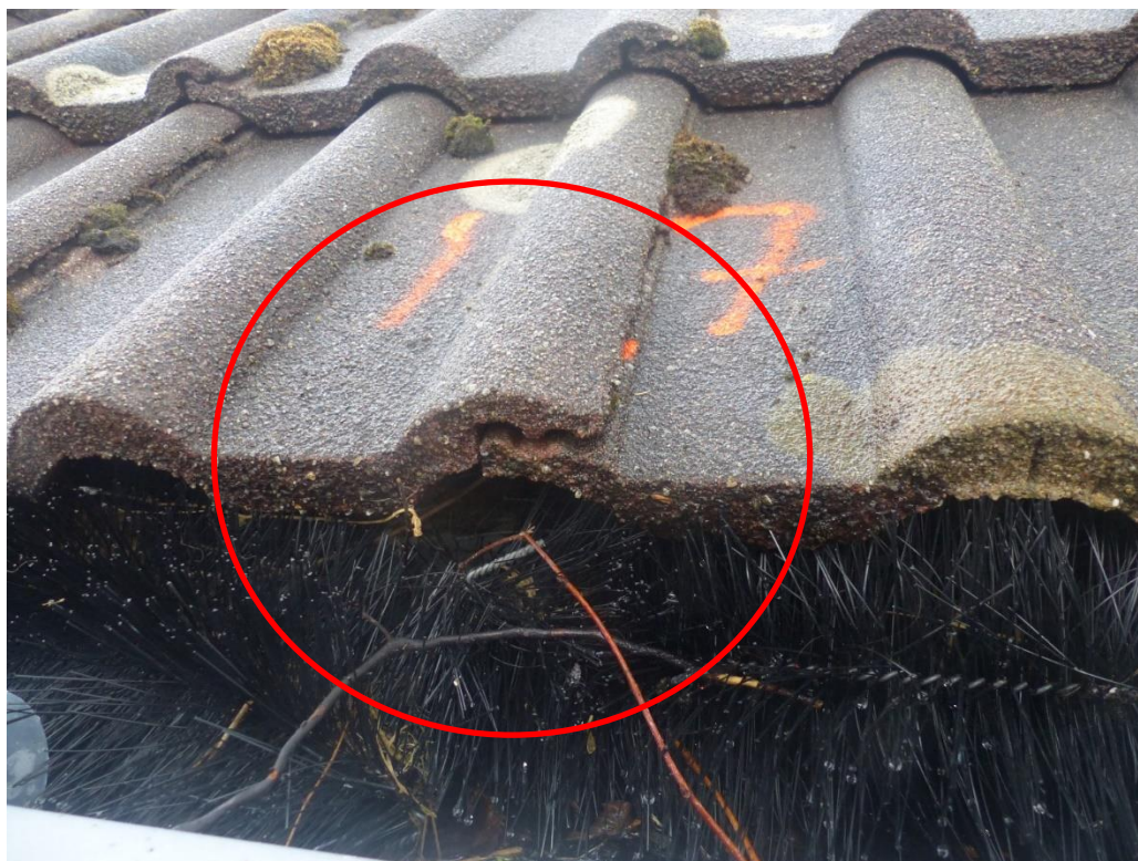
Foto 2. Borstels foutief geplaatst in de goot. Hierdoor kan een huismus alsnog onder het dak komen (rode cirkel) en was hier ook een nest vastgesteld.
