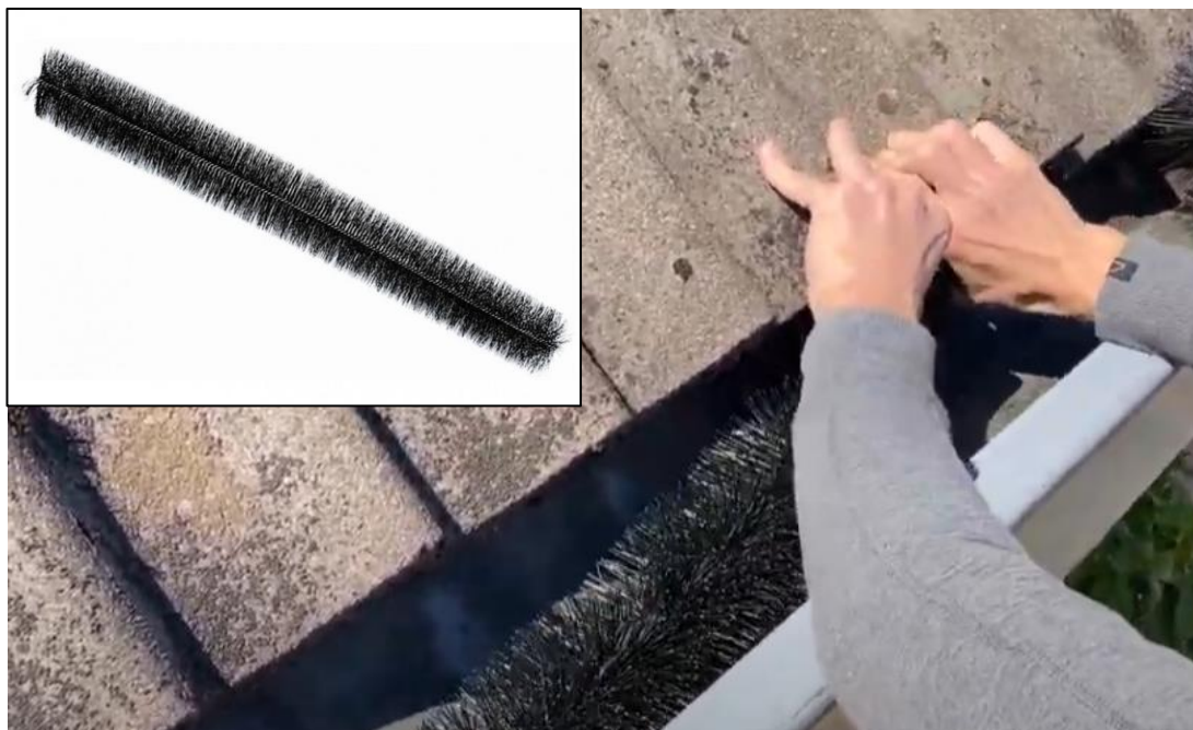
Foto 1. Borstels die gedrukt worden onder de dakpannen.
