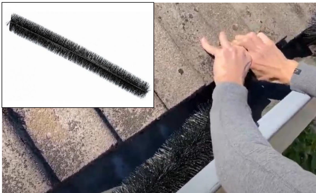
Foto 1. Borstels die gedrukt worden onder de dakpannen.
