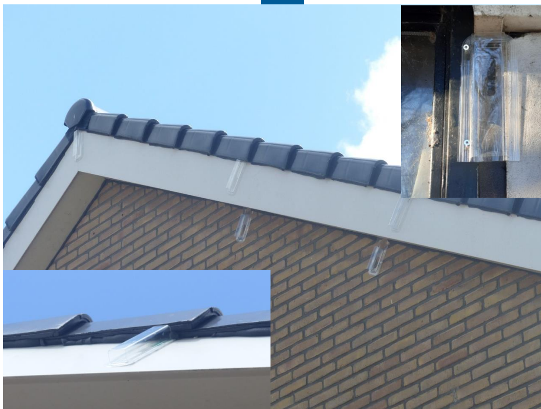
Foto 3. Een aantal voorbeelden van geplaatste exclusion flaps. De overige kieren achter de gevelpannen zijn afgezet met vulschuim.
