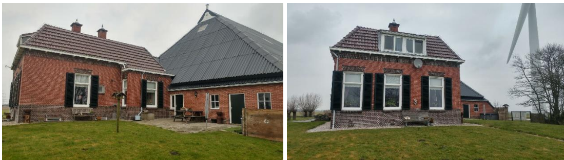
foto's bestaande situatie (voor erf)
