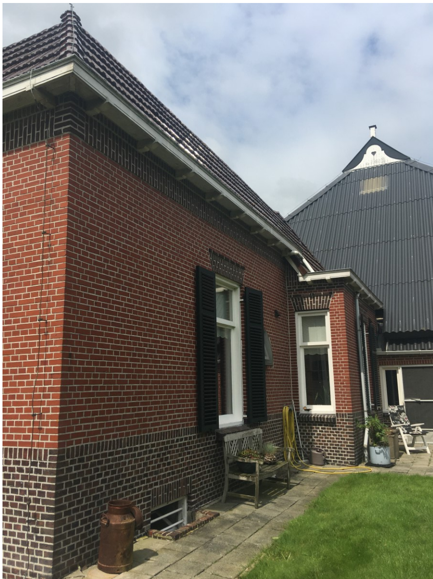
Figuur 4.2 Te slopen voorhuis met achterliggende schuur.
