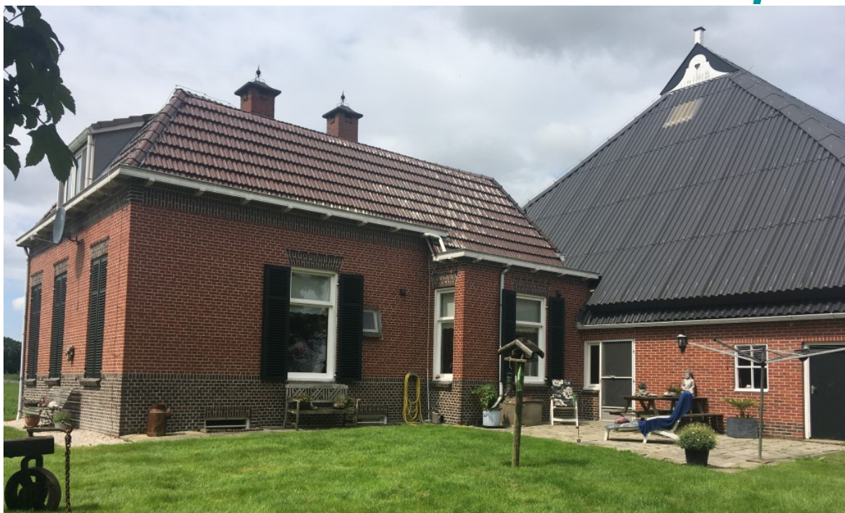
Figuur 1.2 Bestaand voorhuis met achterliggende schuur.
